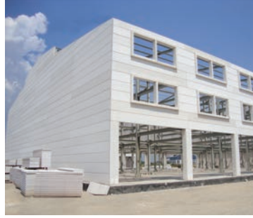
Yatay Duvar Elemanları
