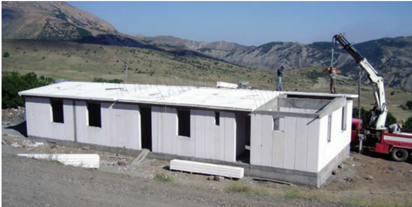
Taşıyıcı Düşey Duvar Elemanları
